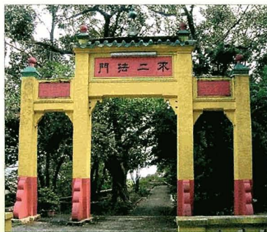
不二法門牌樓正面
